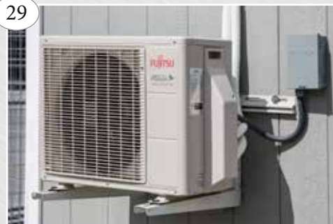
Mini Split Heater/AC Unit • Available in 9000 BTU or 12,000 BTU • Requires 110 Volt A-C
